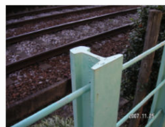
4. レールのガードレール
